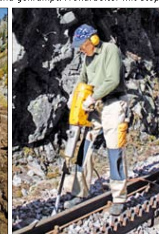
Es wurde geschaufelt, gebaggert und gekrampt: Fronarbeiter mit Stopfmaschine und während der Mittagspause an der Strecke.
